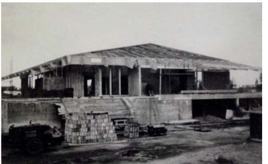
Structure de l'église en béton et toiture en tuiles noires..
