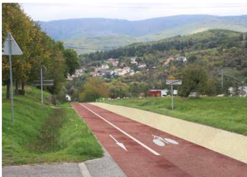
SORTIE DE NEUVE-ÉGLISE SUR LA DÉPARTEMENTALE REMANIÉE
