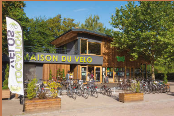
La maison du vélo, ÉPINAL (88), Jean-Luc Gérard Architecte
